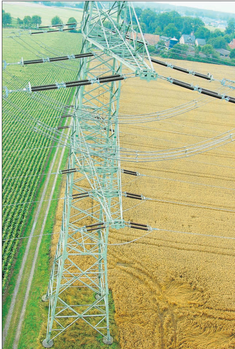
Blick aus dem Hubschrauber auf einem Strommast mit 380-kV-Leitung. Für Masten, die ab April 2008 errichtet worden sind, fällt die Entschädigung höher aus. Foto: Asbrand
